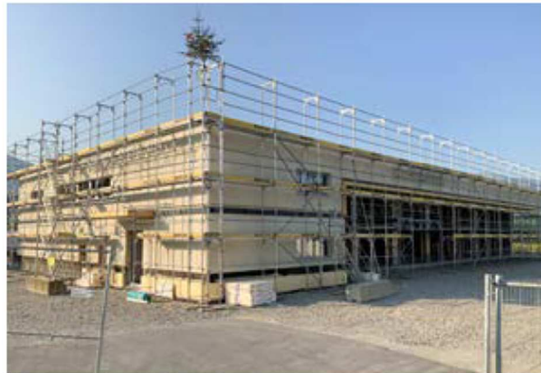
Der Bau schreitet voran. Das neue Feuerwehrdepot feierte vor den Sommerferien Richtfest.
